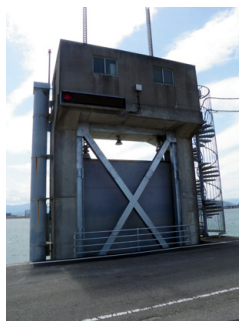
水門の耐震補強(徳島県徳島市)
