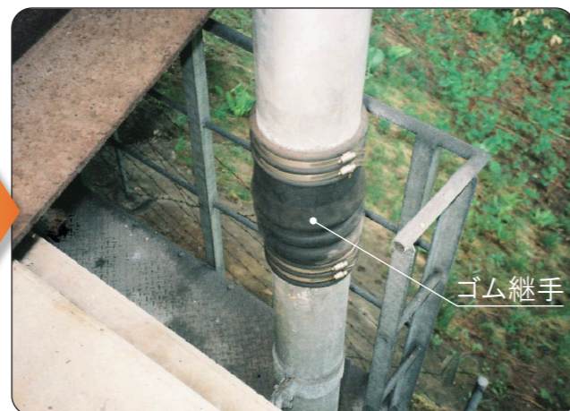
受け桁型式からゴム継手に変更(飛散防止)
