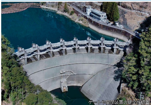
ゲートや開閉装置の健全性調査
