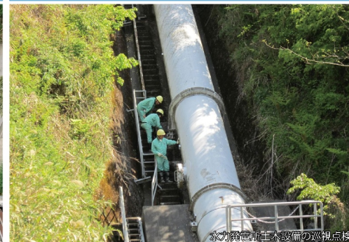
水力発電所主設備の巡視点検
